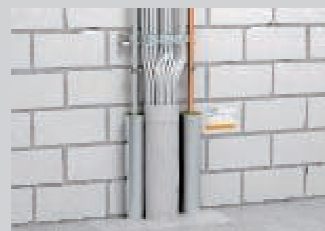
Instalacija protupožarne bandaže bez razmaka od cijevne izolacije Rockwool Conlit
