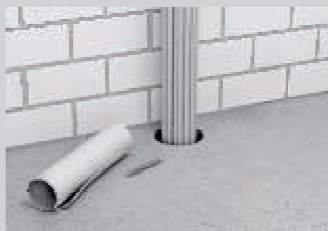
Priprema za zatvaranje kablskih prolaza.
