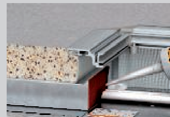
Fuge između kabela i blokova zatvorite pomoću kita FBA-SP.
