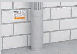
Zatvorite ostatak otvora žbukom i montirajte natpisnu pločicu.
