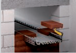
Montaža izrezanih blokova.
