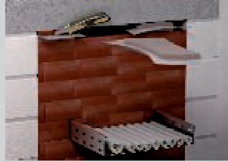
Vakuimirani blokovi za jednostavno zatvaranje preostalih otvora.
