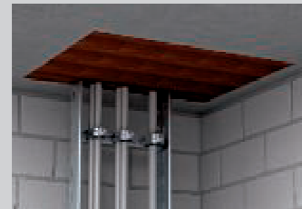
Uspravna ugradnja blokova u stropu.
